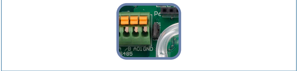
Рис. 5 Соединительная перемычка резистора подключена
